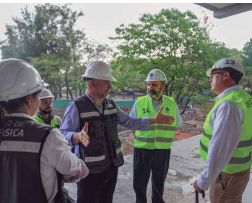
El director de Servicios Generales, Javier González Amaya; el rector Alexander Zatyryka, SJ, y Guillermo Gatt, presidente de ITESO A. C., en las etapas iniciales de la construcción.
