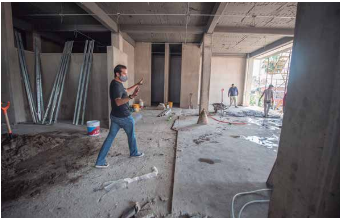
Mane en el espacio del nuevo gimnasio aún en construcción.
