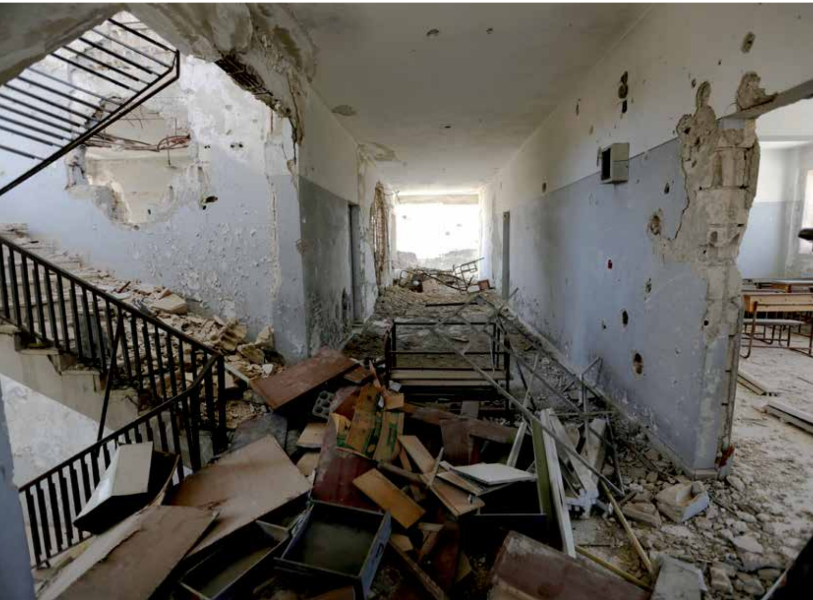
ASÍ LUCE LA ESCUELA SIRIA, LA ESPERANZA , ubicada en la ciudad de Maaret al-Numan. El edificio fue usado por las fuerzas gubernamentales antes de que los rebeldes tomaran el control de esta zona, que se encuentra en la provincia de Idlib.
